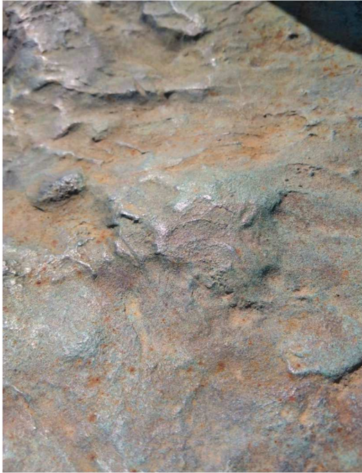
Točkasta hrđa na brončanoj plinti (fotografija gore lijevo) i željezna ispuna evidentirana ispod šinjela sa zapadne strane (unutar pravokutnika) s narančastim oksidima na okolnoj brončanoj stijenci.
