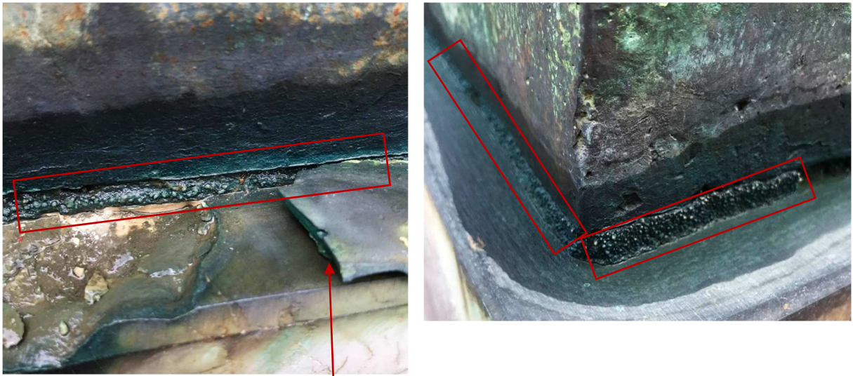
Fotografije cementne ispune na mjestu spajanja brončane plinte s kamenim postamentom. Na većim dijelovima ispuna nedostaje kao i kamena obloga.
