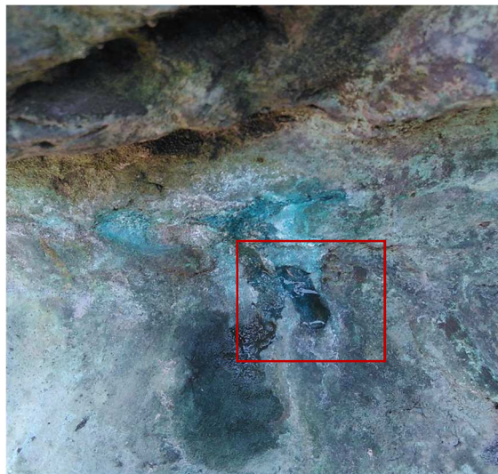
Degradacija površine u vidu nedostatka materijala/otvora na površini stijenke (gore lijevo) i nakupljanje kondenzata na mjestu gdje je bronca izrazito porozna (gore desno, unutar pravokutnika)
