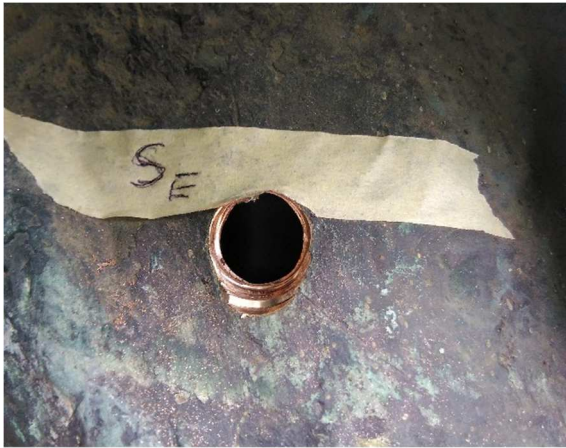
SE- sonda otvorena u svrhu endoskopskog snimanja
